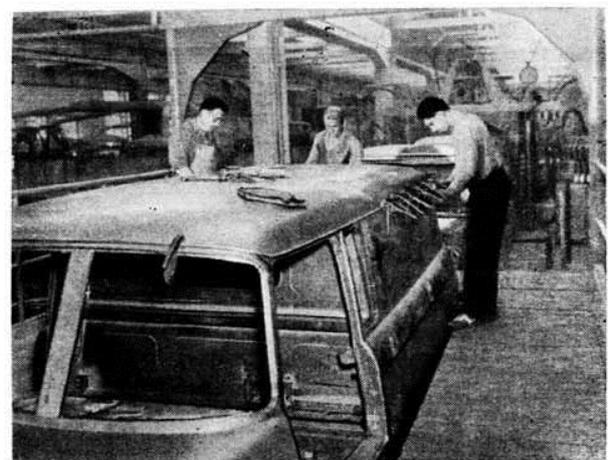
Bild 14. Die Dachschale wird auf die Karosserie aufgepaßt
