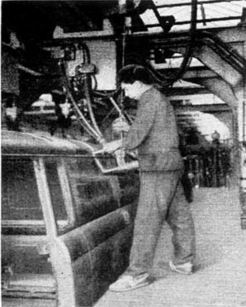
Bild 15. Mit der Handpunktschweißzange wird das Dach mit der Karosserie verpunktet
